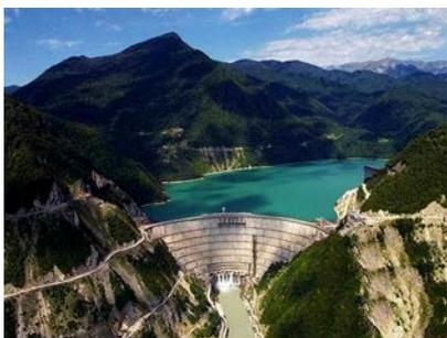
**И**нгур ГЭС - крупнейшая на Кавказе гидроэлектростанция, расположенная в ущелье р. Ингур. Высота плотины составляет 272м. Советские ученые и инженеры смогли решить все технические проблемы возведения арочной плотины ИнгурГЭС, обеспечив тем самым многократный запас прочности сооружения. В 1980г., 5 ноября поставлен под промышленную нагрузку последний, пятый агрегат
